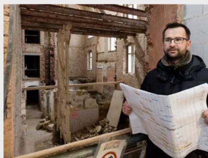
Geschäftsführer Alexander Penther wirft einen Blick auf die Baustelle des Pflegeheims, das für rund sechs Millionen Euro saniert wird. Der Anbau ist schon gut zu erkennen (l.). Die Eingangstür wird demnächst restauriert. © Steffen Unger
